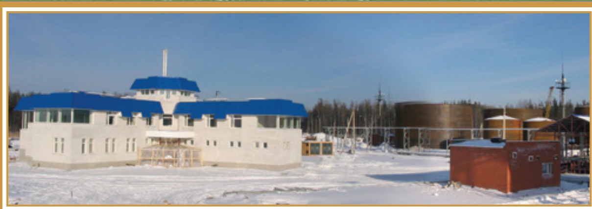
СКЛАД НЕФТЕПРОДУКТОВ ЁМКОСТЬЮ 12,8 ТЫС. М КУБ. В РАЙОНЕ ВИАДУКА НА ТРАССЕ С.-ПЕТЕРБУРГ - КИЕВ
